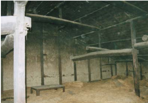
▲再生前建物内観
